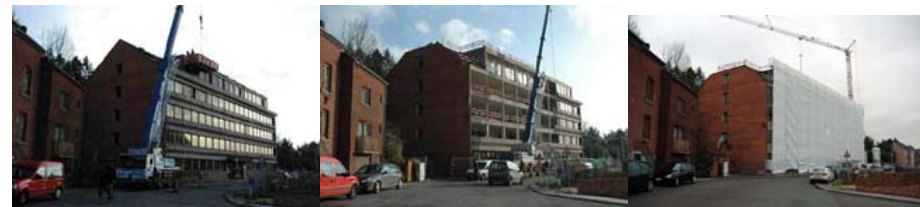
Premières étapes du chantier (octobre 2009– janvier 2010) : démolition de la façade avant
