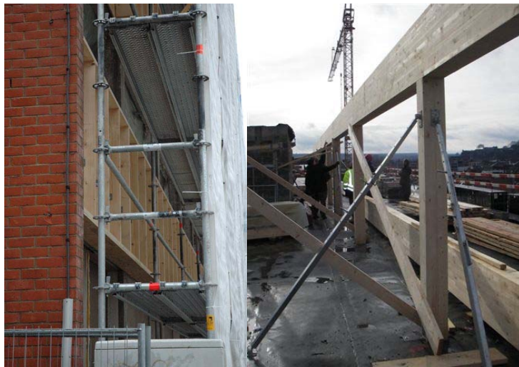
Cconstruction des caissons en bois(en cours) qui recevront la cellulose et structure de l'étage supplémentaire (rez+5).
